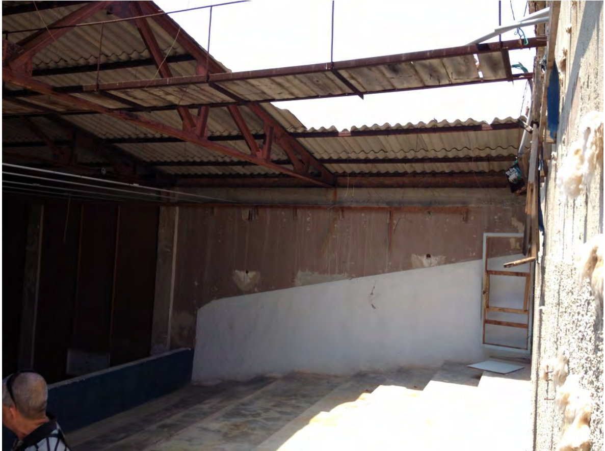
Vista galleria. 20 maggio 2013
